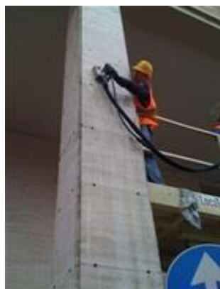
LAVAGGIO PARETI E COLONNE PER ELIMINAZIONE SMOG E IMBRATTAMENTI CON TRATTAMENTO IDROREPELENTE
