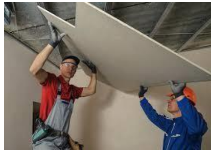
POSA IN OPERA DI CARTONGESSO
