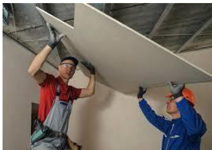
POSA IN OPERA DI CARTONGESSO
