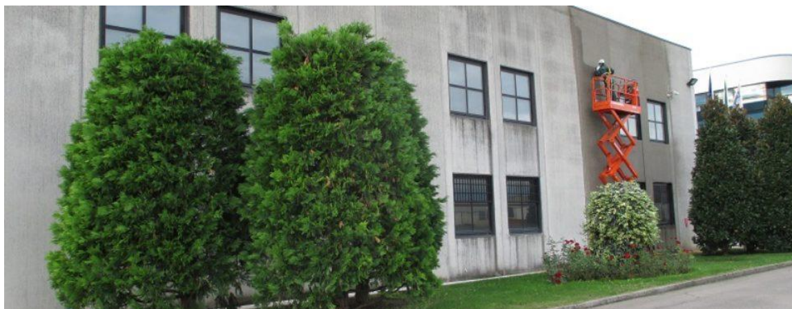
Lavaggio Facciate - Capannoni
