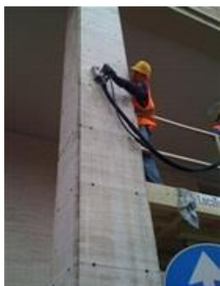
LAVAGGIO PARETI E COLONNE PER ELIMINAZIONE SMOG E IMBRATTAMENTI CON TRATTAMENTO antismog - antigraffiti
